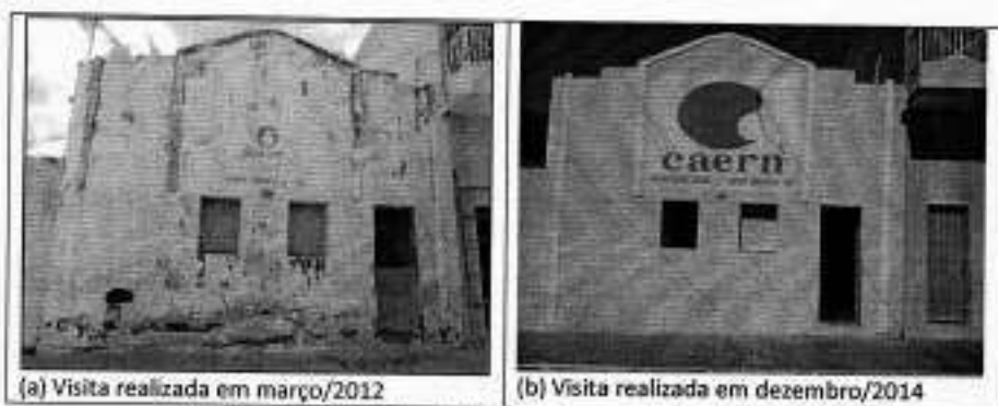
Figura 4. 3 – Escritório local da CAERN, no município de Ouro Branco.
