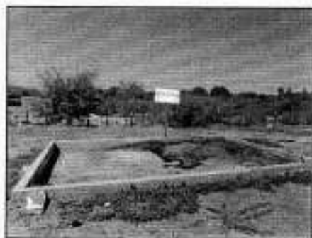
Figura 6. 49 – Esterqueira da Estação de Tratamento de Esgoto do Matadouro. Fonte: CAERN (2013).
