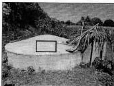
Figura 6. 28 – Ferragem da tampa do poço amazonas do SAA Carnaubinha exposta e com indícios de corrosão. Fonte: CAERN (2013).
