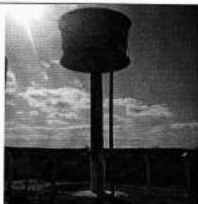
(b) Reservatório do sistema implantado
