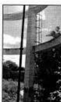
(c) Escada de acesso
