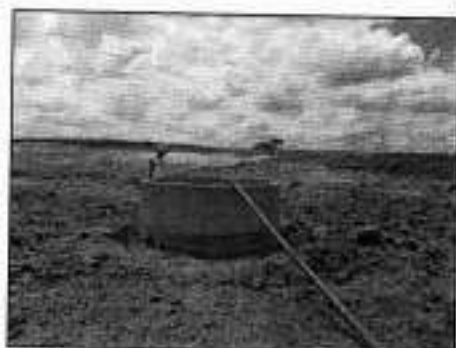
Figura 6. 24 – Poço amazonas que foi instalado no Sítio São Roque de Cima. Fonte: Prefeitura Municipal de Ouro Branco (2013).
