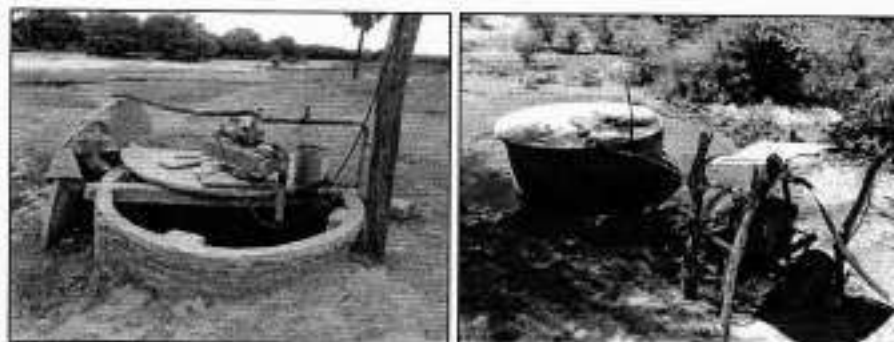
(a) SAA Fechado e Salgadinho – poço descoberto (b) SAA Poção Castelo – poço em área alagada Figura 6. 29 – Poços amazonas dos sistemas de Fechado e Salgadinho e Poção Castelo. Fonte: CAERN (2013).
