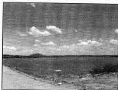
(a) Açude Esguiço
