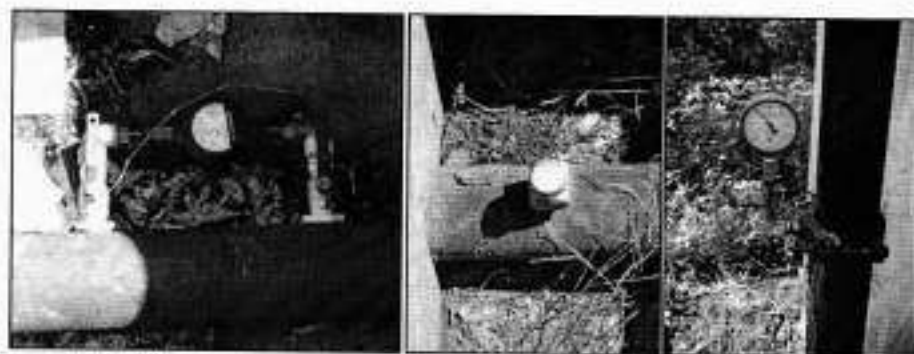
(a) Medidor de volume proporcional (b) Ponto de pitometria (c) Medidor de nível (manômetro)
