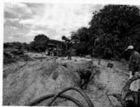
(b) Captação - poço amazonas
