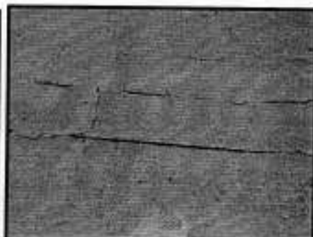
Figura 6. 28 – Ferragem da tampa do poço amazonas do SAA Carnaubinha exposta e com indícios de corrosão. Fonte: CAERN (2013).
