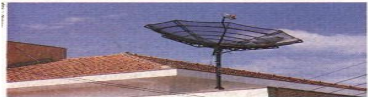
Ao captar ondas eletromagnéticas, as antenas parabólicas permitem comunicações a longas distâncias.
