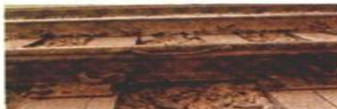
Os trilhos têm separações porque sofrem dilatação linear.
