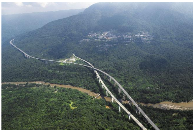
Figura 01. A Rodovia dos Imigrantes, que liga a Região Metropolitana de São Paulo à Baixada Santista, possui uma série de pontes, viadutos e túneis para transpor os obstáculos da Serra do Mar (SP, 2013).
